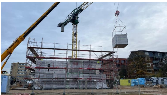
Errichtung Gebäude 9a (Foto: Solid Modulbau, 02/2024)
